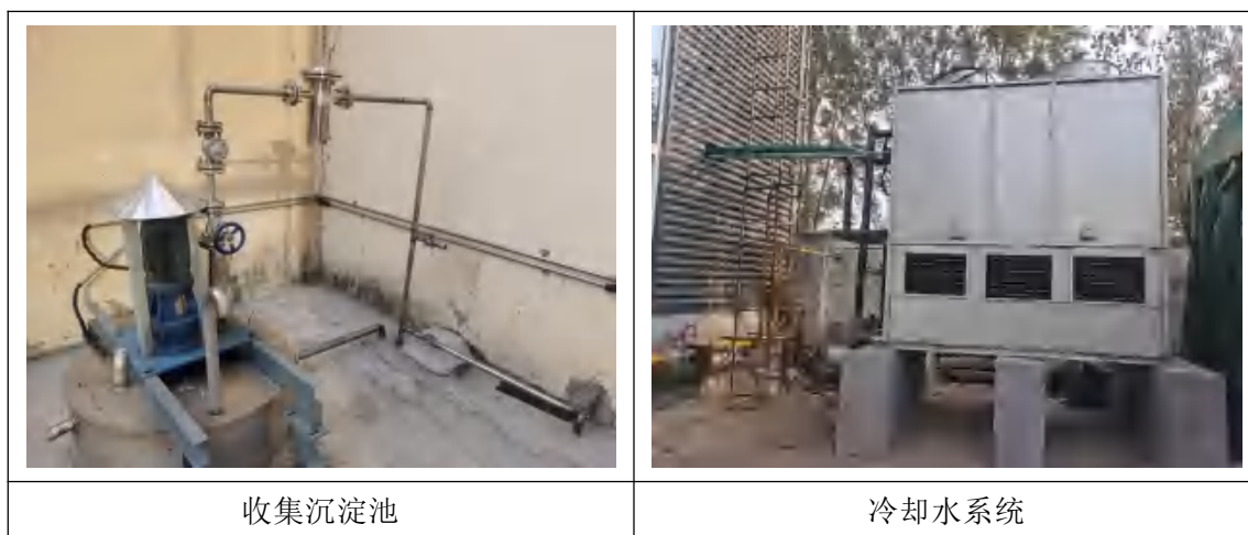
图 4-1 废水处理设施实际建设情况
